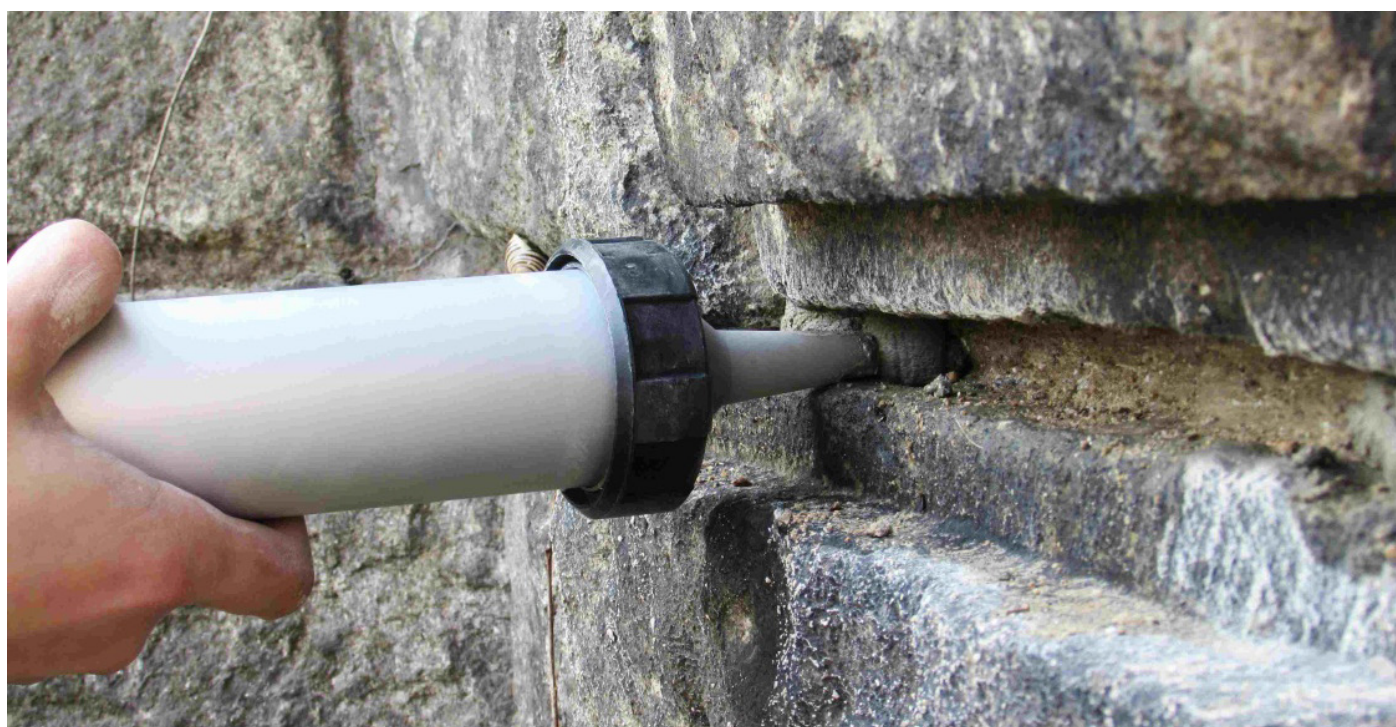
Obr. č. 8 Fotografie aplikace spárovkové hmoty
