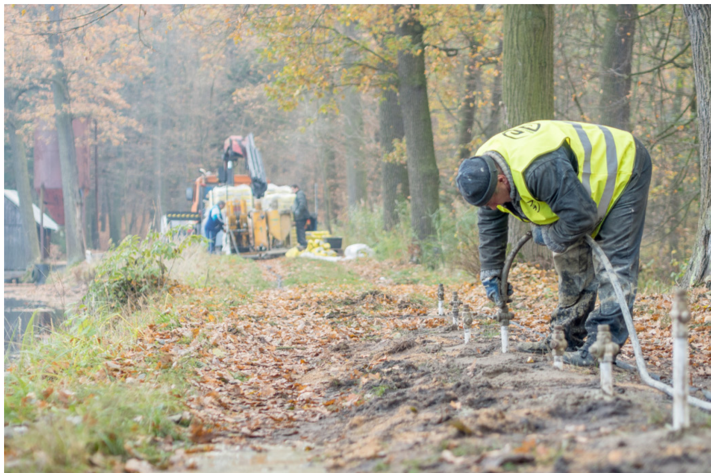
Obr. č. 2 Ověření technologie sanace sypaných hrází
