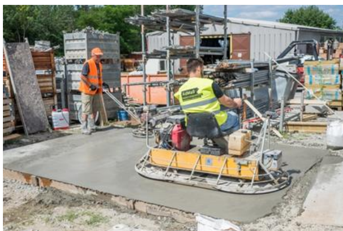
Obr. č. 3 Ověření technologie provádění průmyslových podlah pro projekt TA04010143
