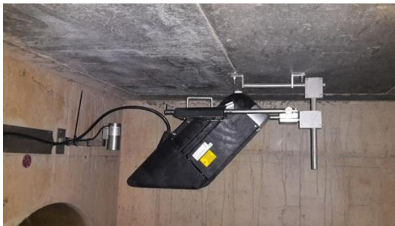
Obr. č. 18 Instalovaná laserová sonda ISCO
