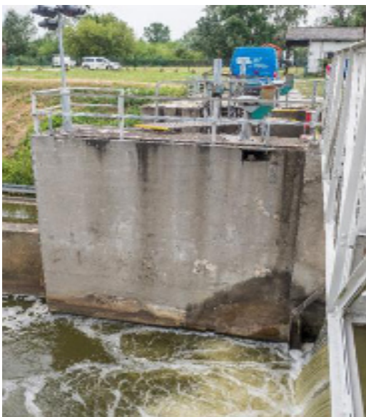
Obr. č. 2: Fotodokumentace stavu betonové konstrukce jezu
