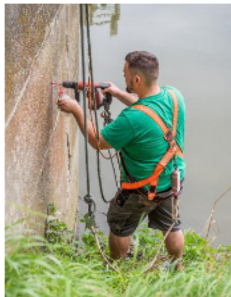
Obr. č. 3: Stanovení hloubky karbonatace na konstrukci jezu
