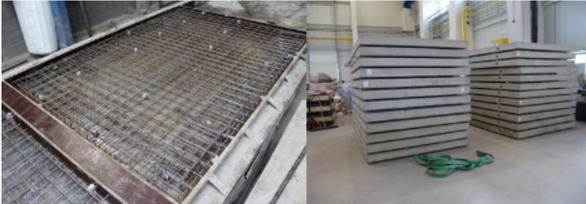
Obr. č. 25: a, Armování panelu; b, Uskladnění panelů v areálu AdMaS
