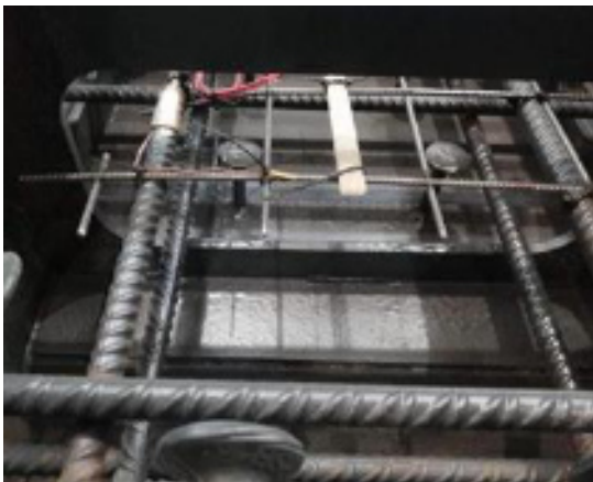
Obr. č. 12: Příprava tenzometrů pro stanovení smrštění betonu
