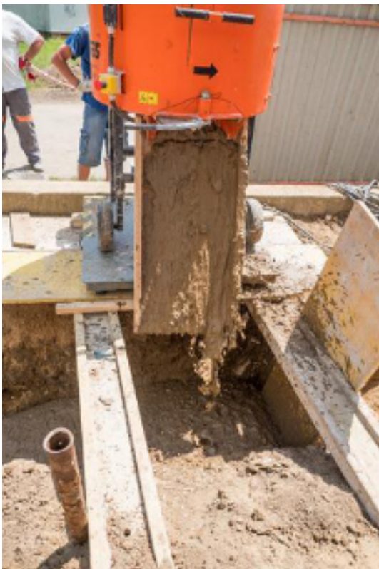
Obr. č. 6: Experimentální ověření ztekuceních zemin (aplikace „in situ“)
