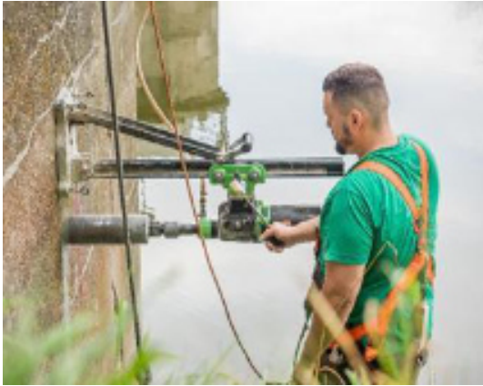
Obr. č. 4: Odběr jádrového vývrtu na konstrukci jezu
