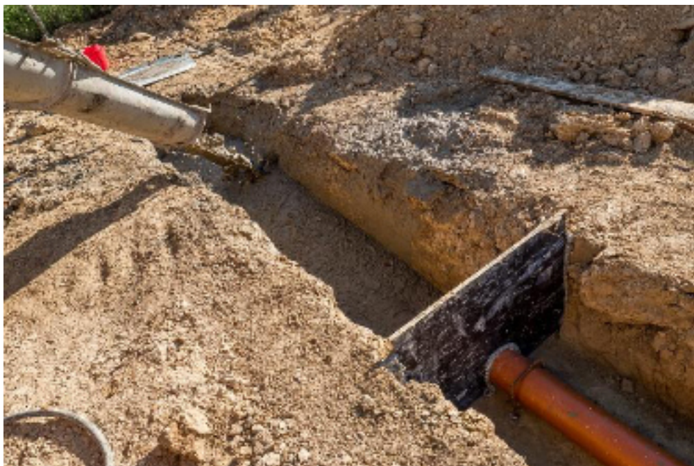
Obrázek 6: Rovnoměrné odlévání směsi do výkopu
