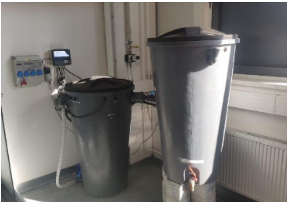
Obrázek 19: Systém čištění šedých vod; lokalita AdMaS
