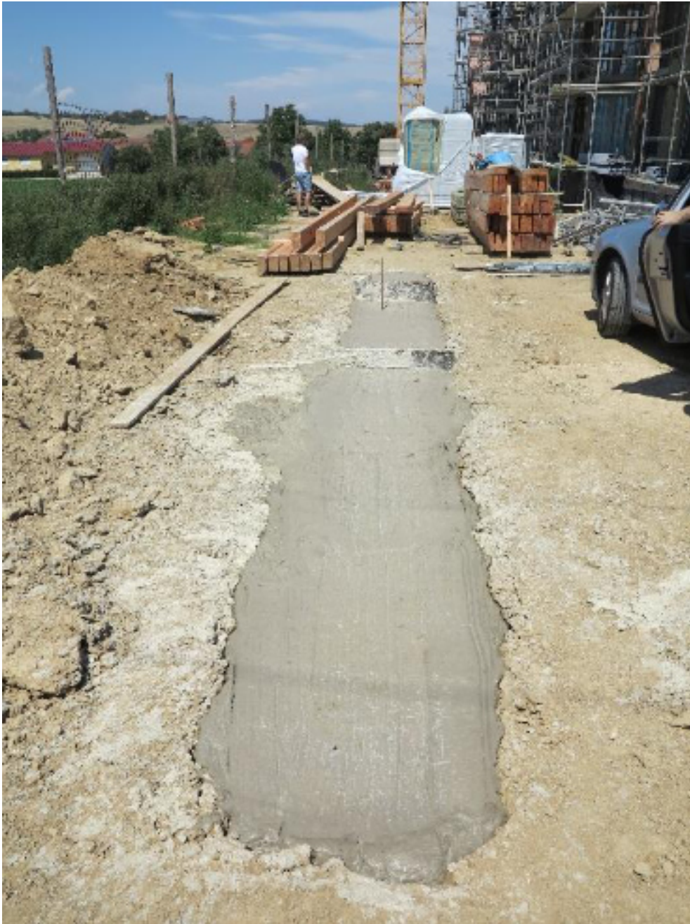
Obrázek 7: Zálivka 24 h od provedení
